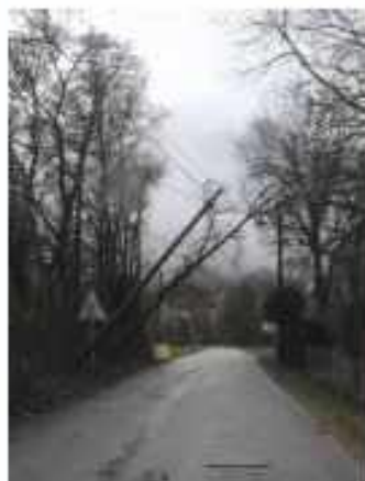
Chutes d'arbre et de poteaux «télécom» suite à des vents violents hameaux de l' Eglise, Château Bas, Le Serre
