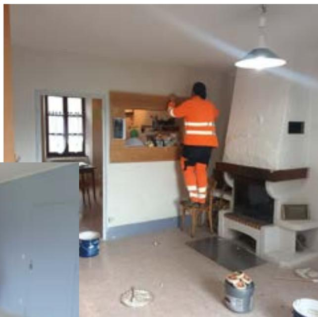
Travaux de rénovation salle de la cantine : rebouchage, plâtrage, sablage, lissage, puis peinture...
