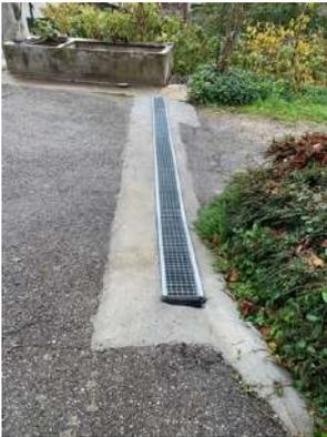
Contrôle des eaux de ruissellement par installation d'une grille raccordée au réseau d'assainissement, Impasse du Four à Château-Méa
